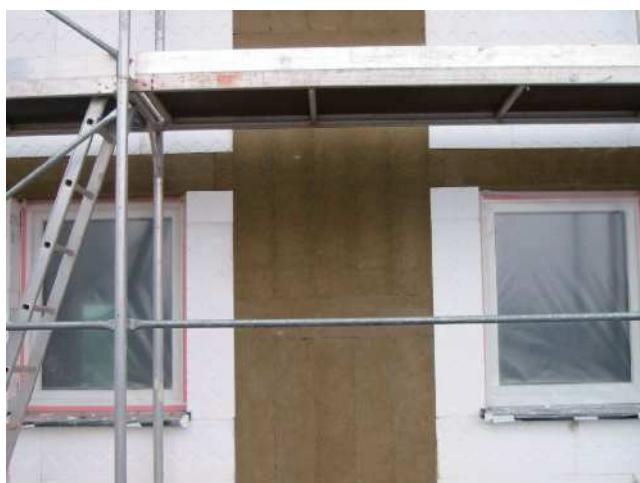
图 5-6：用聚苯板制作的外墙外保温系统。在防火隔离区段的边界处（多层居住建筑）和窗户上部用岩棉制作防火隔离带。达姆施塔特的住宅建筑项目
