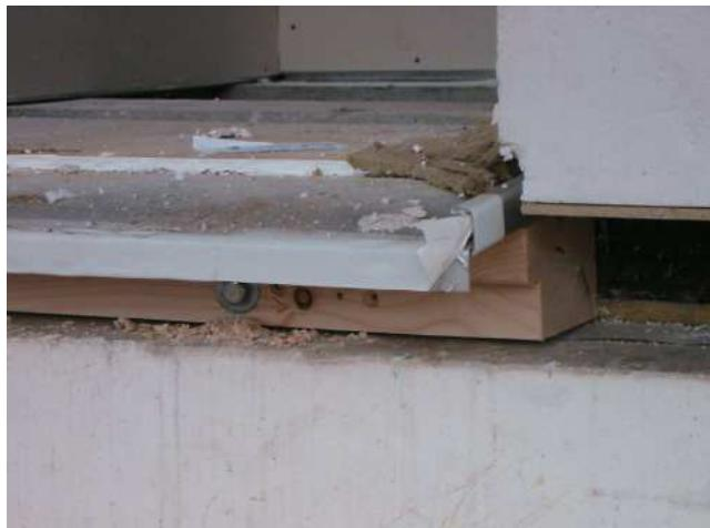
图 5-5：在门联窗下面的踩踏安全木条。达姆施塔特的住宅建筑项目
