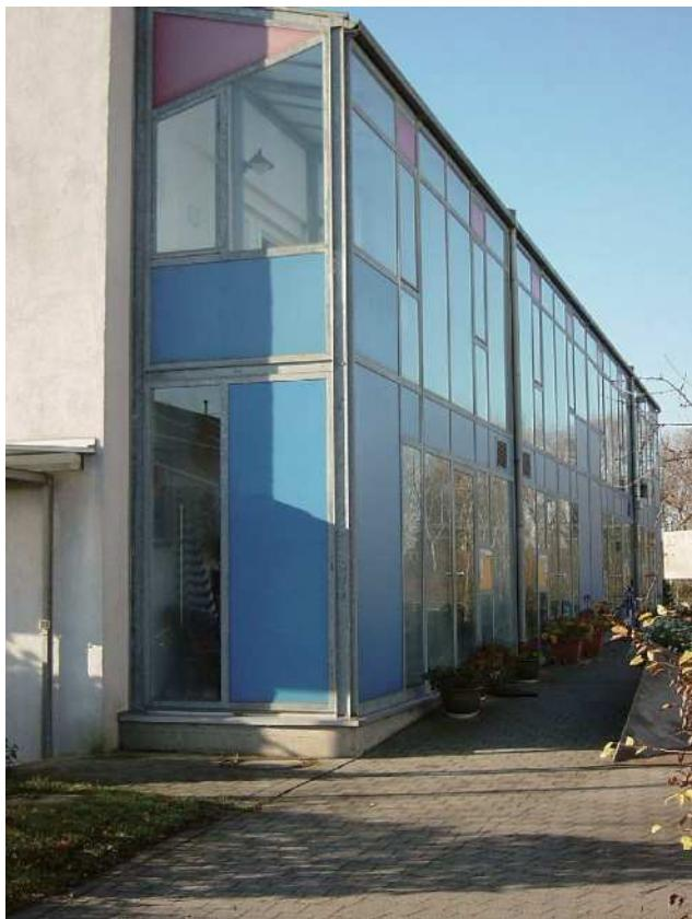
图 2-7：楼梯间作为非供暖建筑装在供暖围护结构的外侧。可以从楼梯间通过简单的门进入不供暖地下室
