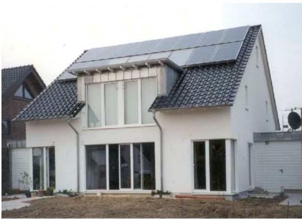
图 2-4: 在传统建筑上也可以实现大面积的南向窗户。二楼的老虎窗为实现被动房标准做了优化
