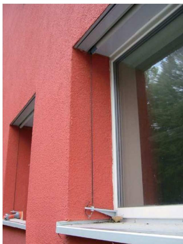
图 3-42：窗框用保温覆盖的洞口，卷帘作为遮阳装置，
