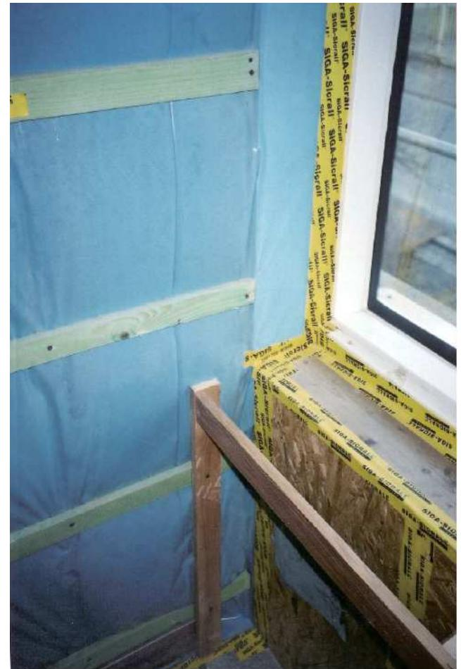
图 3-28：刨花板接缝处和用于在空腔内灌装保温絮的孔洞（灰色）上的气密性胶条（黄色）
