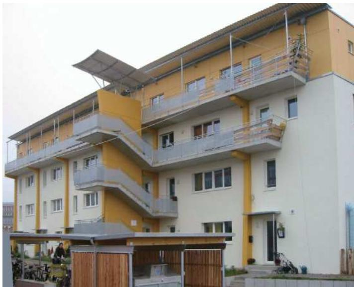
图 2-10：在该被动房上，连廊和楼梯间支撑在独立的混凝土支架上。支架全部位于外墙外保温系统的外面（白色部分），只有为数不多的墙体锚固点。这样就避免了热桥。最上一层采用轻木结构。弗莱堡市沃邦小区的被动房。
