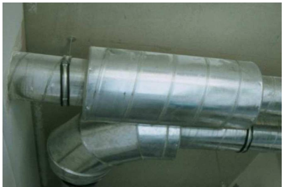
应该用盖子保护以防止脏物进入消声器。只要工地上还有扬尘，安装好的管段也应该采取防护措施
