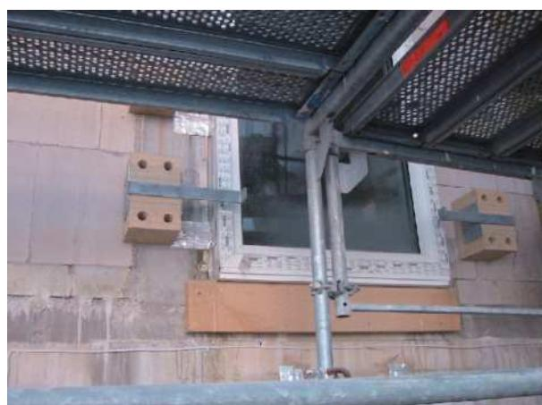
图 3-9：利用高强度再生聚氨酯 [ $\lambda=0.075\text{W}/(\text{m}\cdot\text{K})$ ] 制作窗户和栏杆（防护栏杆）的安装预埋件
