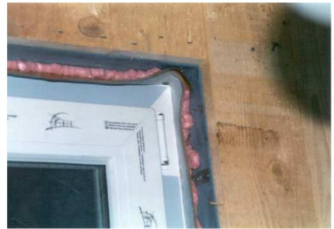
图 3-27：已经粘贴好气密性薄膜的窗户
