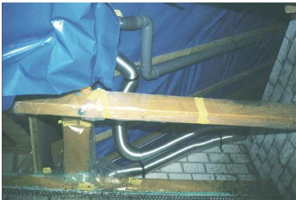
图 5-9：这种节点处理是几乎无法挽救的。这里横梁、新风管道和污水管道纵横交错，无法识别气密层位置
