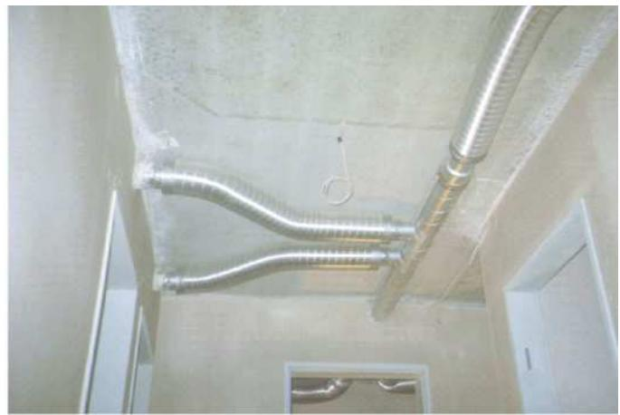
图 2-19：很好的范例。在多层居住建筑上送风和排风管网布置很紧凑。风机、管道和消音器全部布置在浴室和过道的吊顶里面。8户共用的热回收新风机组布置在房顶上
