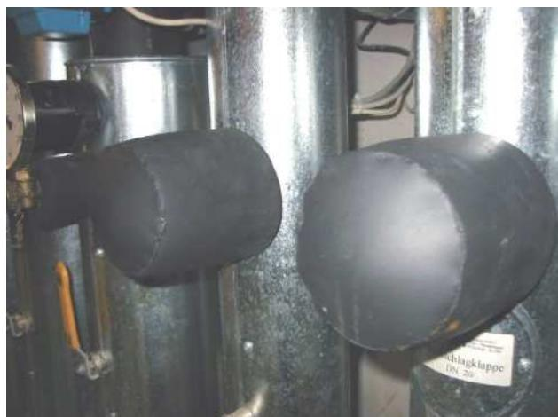
图 5-25：利用合体的保温罩对阀门进行保温，不影响操作和检修
