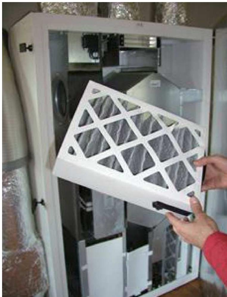
图 3-48：必须定期更换新风机组的过滤器
