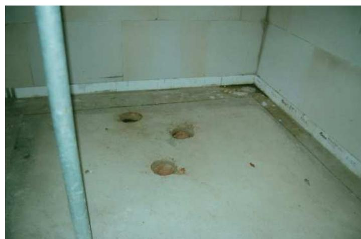
图 3-7：混凝土底板与上面墙体的结合部。为了进行热断桥，墙体可以砌在一排加气混凝土块或导热系数较小的类似材料上 [ $\lambda \leq 0.1 \text{ W}/(\text{m} \cdot \text{K})$ ]，也可参见图 3-19
