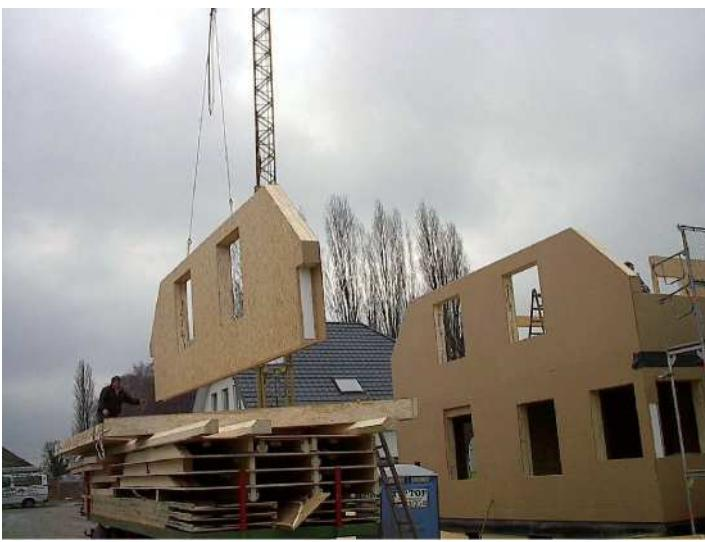
图 3-6：预制的木框架墙体结构
