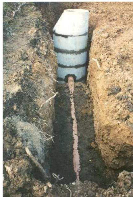
图 5-21：房子周围的地理管，应注意管子密封性，落差均匀，没有囊弯
