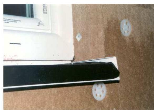
图 3-37：在木纤维板构成的外墙外保温系统中，窗户与两侧洞口和胸墙处的节点
