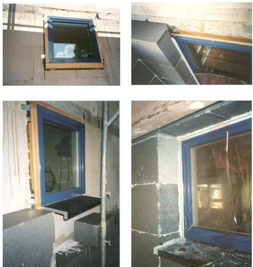
除了保温空腔，也应防止水或者水泥和砂浆对材料保温性能的影响。所以必须注意在施工期间对保温材料做好充分遮挡。特别是玻璃棉吸水性很强，湿的玻璃棉没有保温性能，而且风干非常麻烦。
