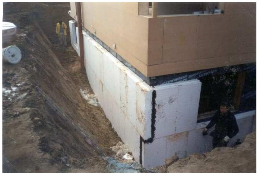
双层砌体的墙体构造对于被动房要求的保温厚度原则上是可能的，如果外侧墙体用不锈钢锚固件固定的话。这种体系可能需要申请认证。
