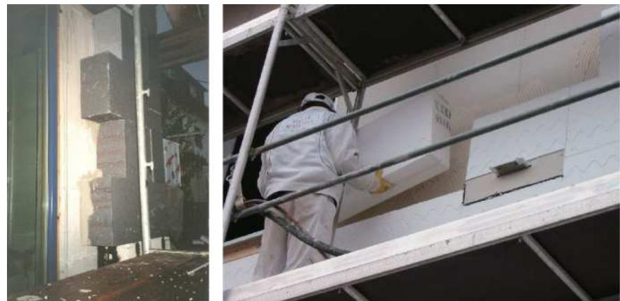
采用吹入式保温材料时，应该抽检内部空间是否填满。同样应该抽样检查吹入材料的沉降情况。应该向供应商索取经过起审查的材料沉降性能证明。施工企业必须知道使用这种材料时允许的最大连续空腔，以免发生显著的沉降收缩。
