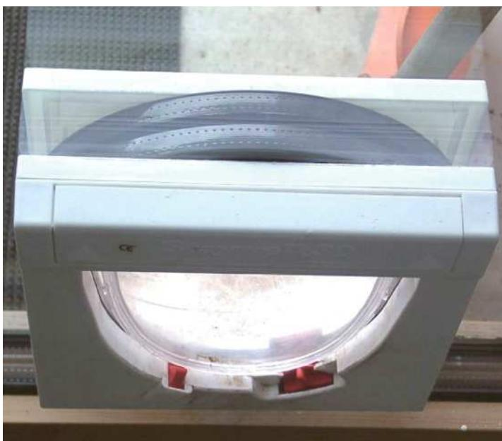
在弗莱堡被动房小区里实现了一种更简单的办法（图 2-10）。将一个带毛刷密封和磁性开门阻尼器的普通猫洞挡板装在一个传热系数为  $0.8W/(m^2 \cdot K)$  的不透明板里，然后装在窗户下面的墙上，而不是玻璃里面。这种门有足够的气密性，做风门测试时只有轻微泄漏
