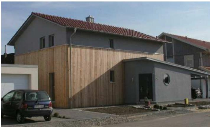
图 3-45：门斗为户外和居室建立了过渡区。必须注意由户门构成保温和气密层，门斗的外门可以比较简单
