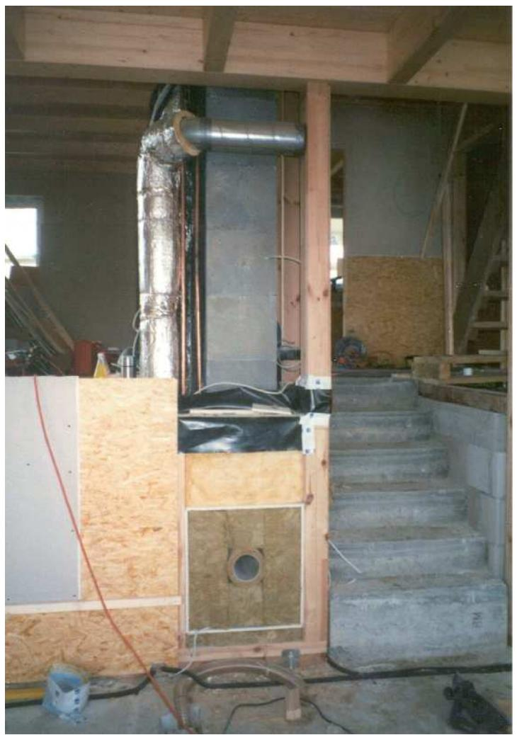
从以上情况可以理解，为什么对在被动房内布置固体燃料锅炉会有这么多不同意见。绝对不可忽视安全要求<sup>[24]</sup>。原则上应该采用气密性的壁炉，燃烧空气管道和排烟管道也必须保证气密性。预计不久就会有新的研发成果<sup>[56]</sup>。
