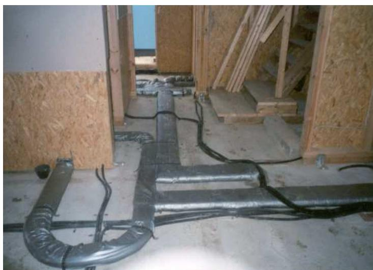
图 3-50：扁风道可以安装在地坪构造层内或吊顶内以节约空间。但是要注意，管网不能太长，以减少阻力损失。见图 2-17 和图 2-18 的说明
